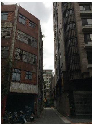
基地側巷建築物現況照片
